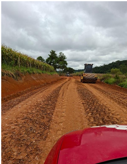
Estado inicial da regularização, de base adequada para pavimentação.
