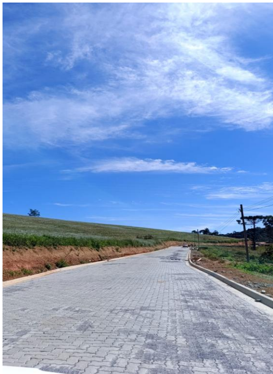
Foto 1: Assentamento de blocos tipo 16 faces
