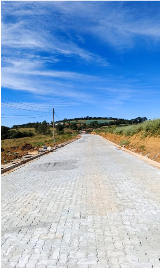
Foto 5: Assentamento de blocos tipo 16 faces
