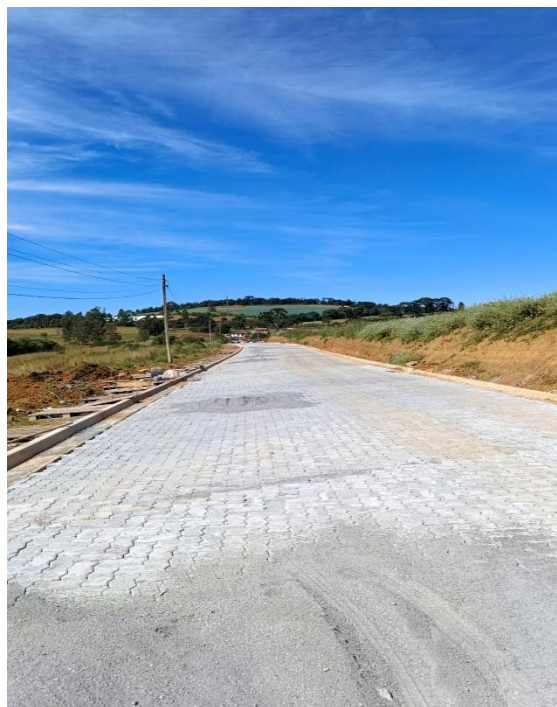
Foto 4: Lançamento da camada de areia
