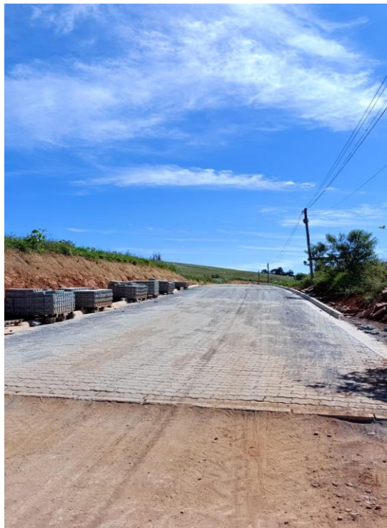
Foto 2: Assentamento de blocos tipo 16 faces
