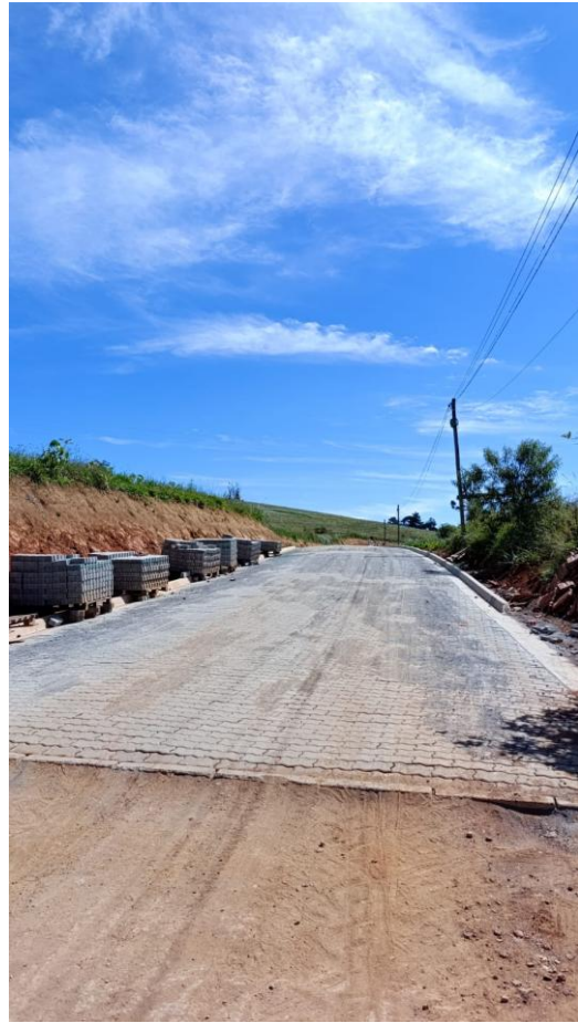
Foto 6: Assentamento de blocos tipo 16 faces
