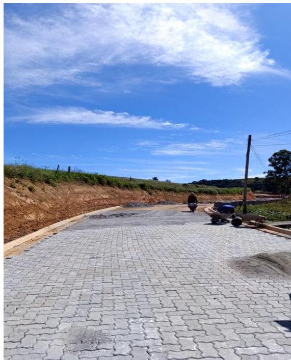
Foto 3: Lançamento da camada de areia
